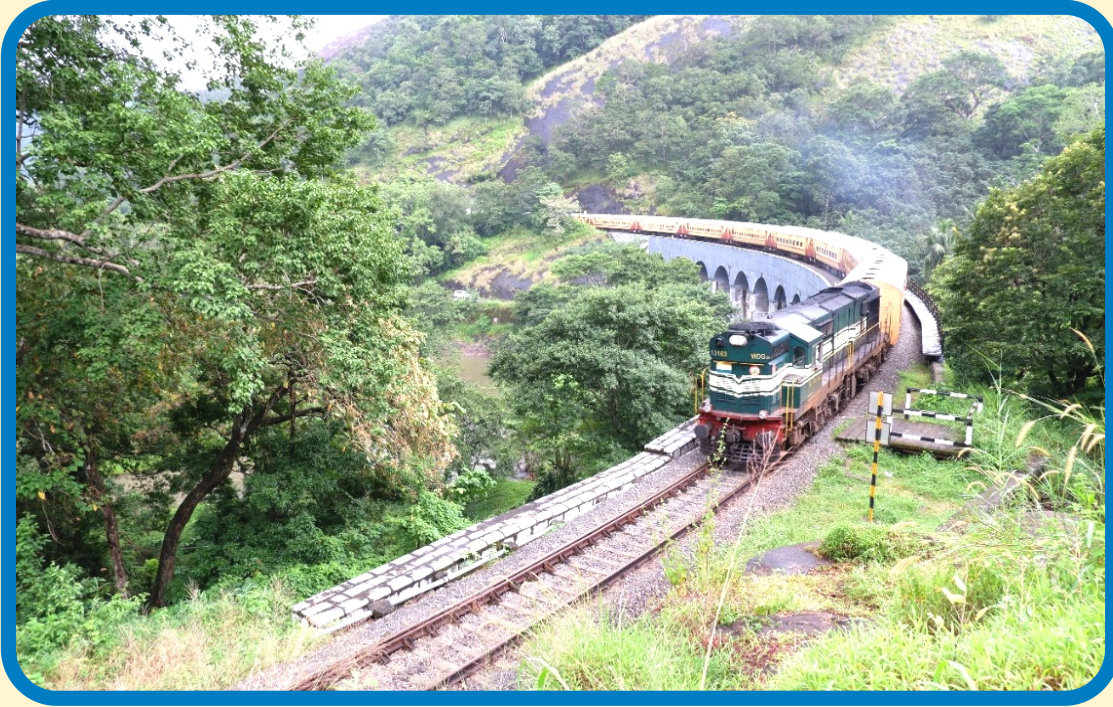
13 स्पेन पुल, तेनमलै 13 Span Bridge, Tenmalai
